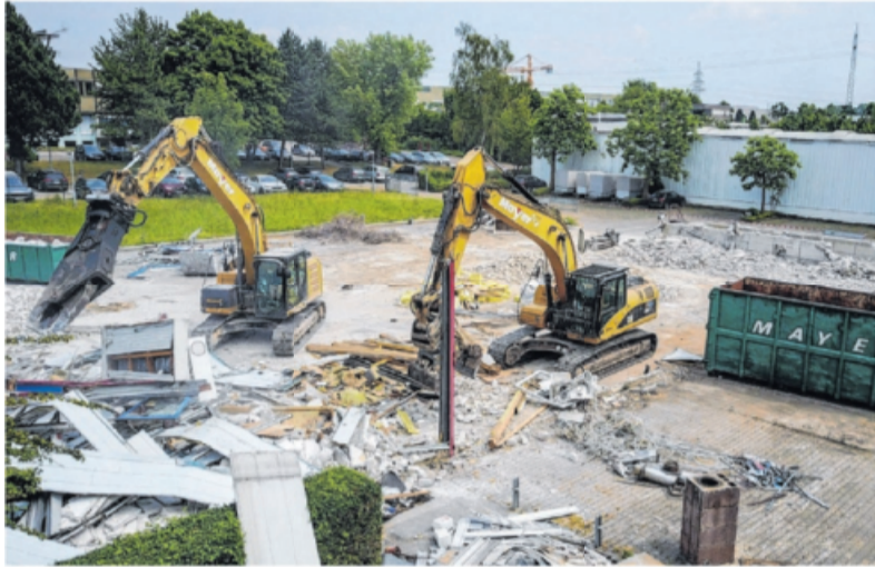
Abbruch ist eines der zahlreichen Geschäftsfelder des Unternehmens. Fotos: Eugen Mayer GmbH & Co. KG
